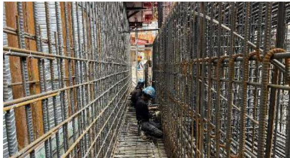
第2期工事の様子
