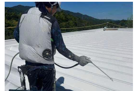
工場屋根の遮熱塗装施工
