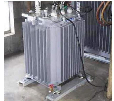
工場設備の変圧器更新
