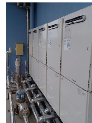
福祉施設の給湯器更新
