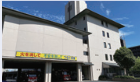
松江市消防本部
