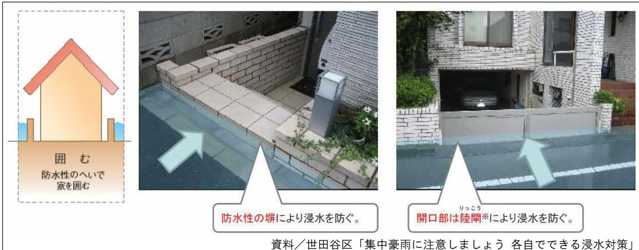
また、屋外に設置された電気設備に対する水防ラインの設定も考えられ、塀の設置等の対策により浸水防止を図ることができる。
