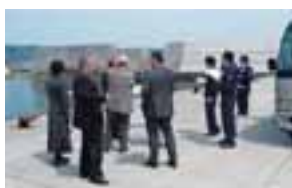
津波で破壊された堤防を視察（宮古市）
