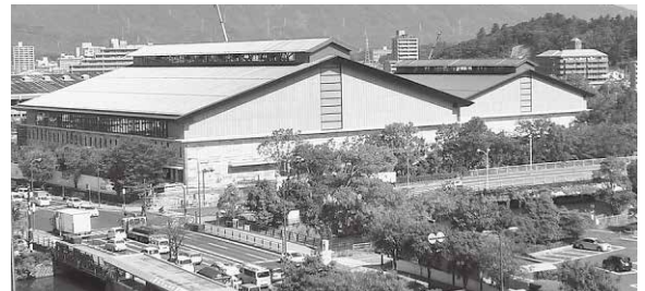
〈建設の進む新松江市総合体育館〉
