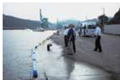
釜石市（釜石湾の被害状況を視察）
