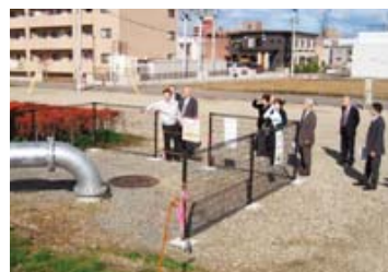
一定の雨量に達すると自動でスイッチが入る常設ポンプ場視察（秋田県大仙市）
