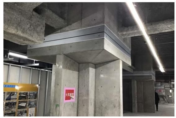
免震装置を耐火材料で覆いました。
