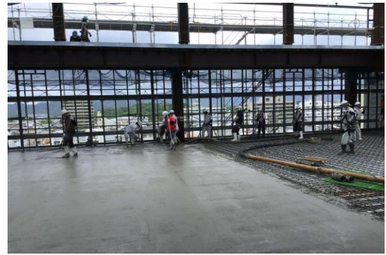
各階の床の整備を進めています。
