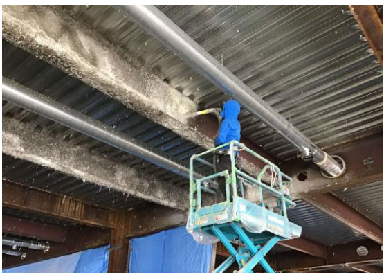
ロックウールを吹き付けています。これにより、火災時に熱で鉄骨が変形するのを防ぎます。
