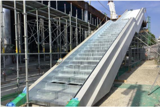
地上からテラスへ上がる階段を造っています。
