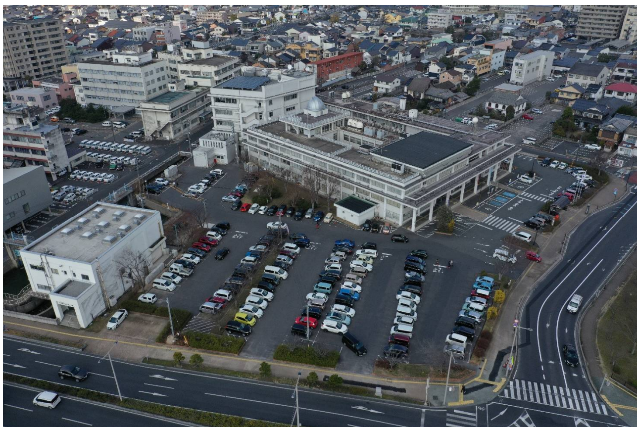
■ 令和3年2月中旬撮影（工事施工前）
