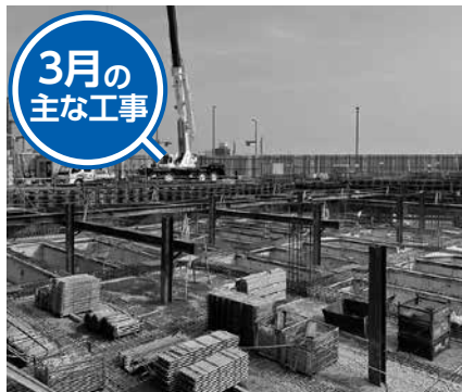
山留鉄骨を撤去した現場の様子 (3月撮影)
