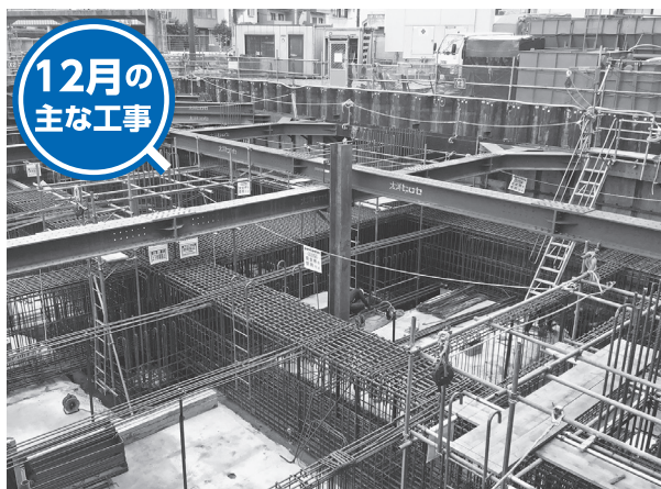
新庁舎建設工事現場（12月撮影）
