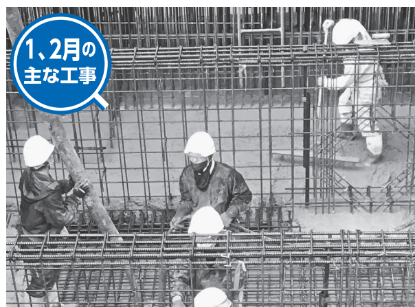
コンクリート打設工事の様子（1月撮影）
