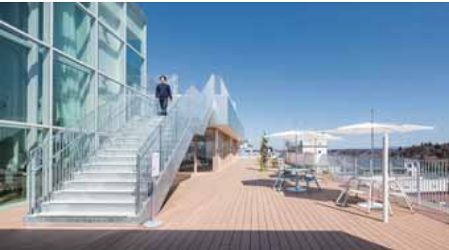
デッキ仕上(再生材ウッドデッキ)のテラスの例
