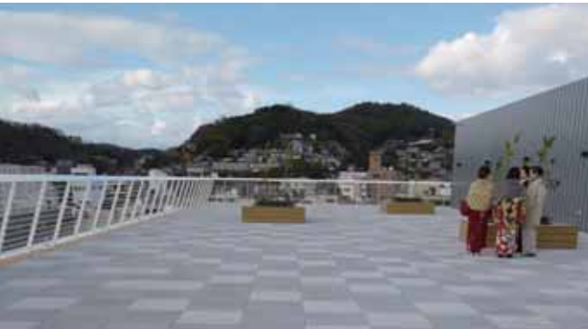
デッキ仕上(コンクリート平板)のテラスの例
