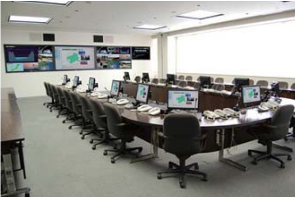
防災センターの例
