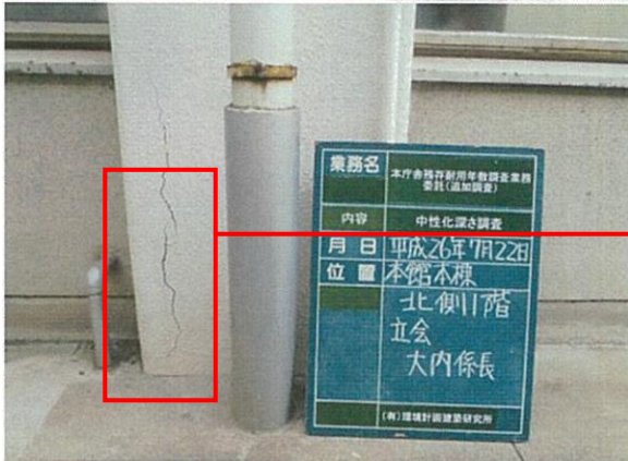
写真1 本館本棟 北側柱脚
