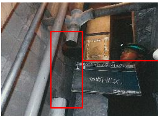
写真11 本館 汚水管調査 3階男子便所のPS内の縦管及び継ぎ手を切断して内部の状況を調査。
