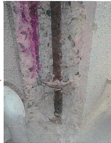
写真2 本館本棟 北側柱脚
