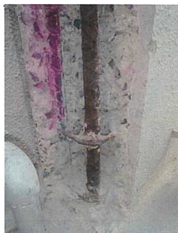
写真2 本館本棟 北側柱脚
