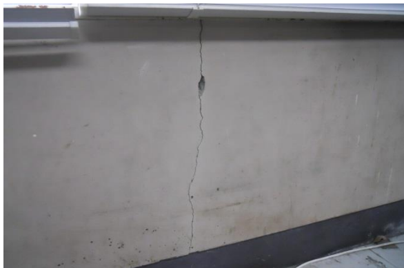
写真7 本館 内部壁 屋内壁や梁型・柱型にもクラックが見られる。
