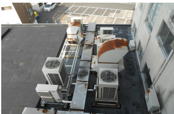
写真10 第4別館 屋上にある設備機器 設備機器は耐用年数を経過している。屋外にある機器は錆が見られる。
