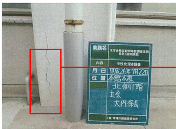
写真1 本館本棟 北側柱脚
