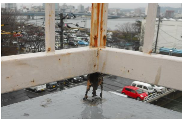
写真9 別館 外部金物の腐食 外部の金物（手すりなど）が錆により腐食している。
