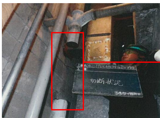
写真11 本館 污水管調査 3階男子便所のP S内の縦管及び継ぎ手を切断して内部の状況を調査。
