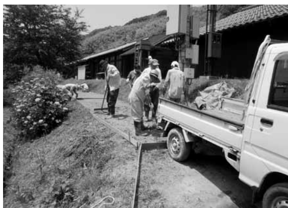
農道のコンクリート舗装作業
