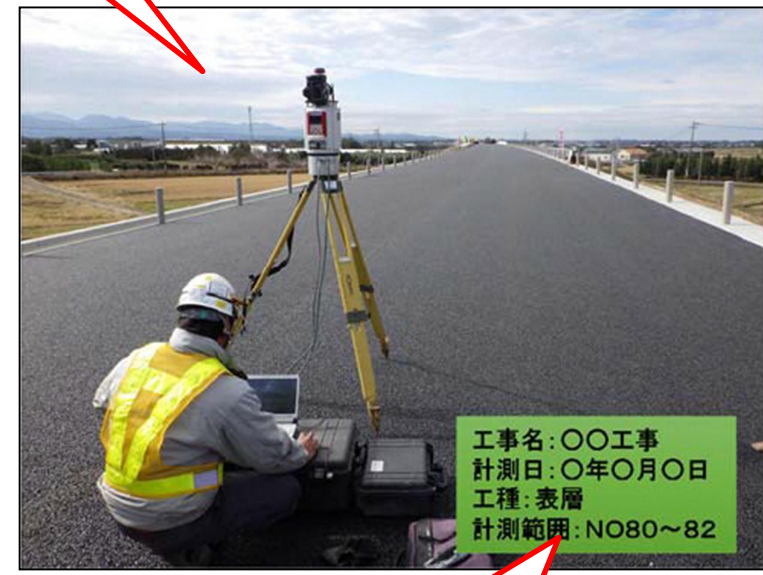
TLS 出来形管理写真(例)
