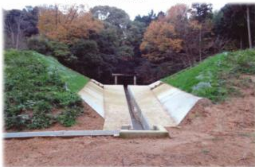
【ため池廃止工事施工例】（堤体開削）
