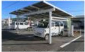
ソーラーカーポート設置 (玉湯公民館)
