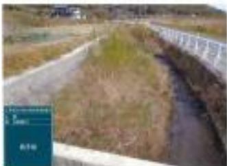
稲積川(美保関町) 作業前
