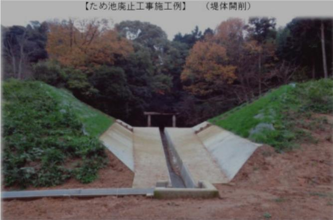
【ため池廃止工事施工例】（堤体開削）
