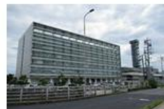
㉒跡地広場南側(合同庁舎)
