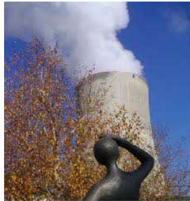
冷却塔から出る水蒸気
