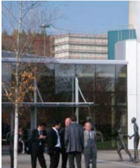
後ろの足場のある建物 使用済み燃料貯蔵施設(増設) (1000体分)
