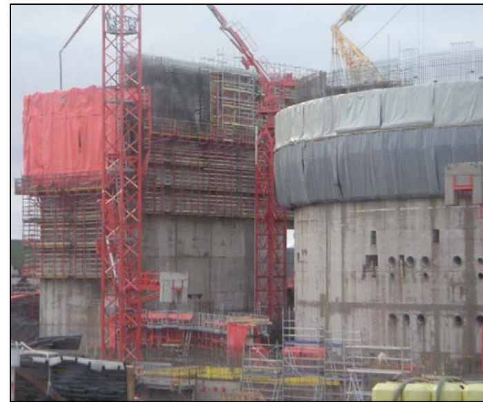
フィンランドでの原子炉建家建設現場 外側容器（左）は外部からの 航空機衝突防壁の役目もある
