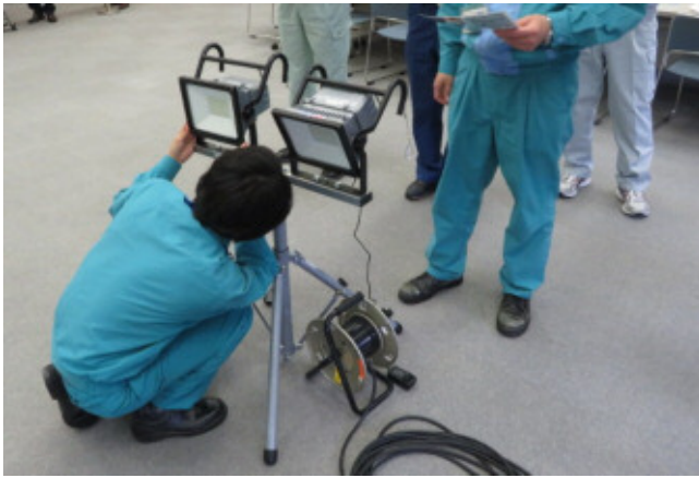
LEDライトの外観点検
