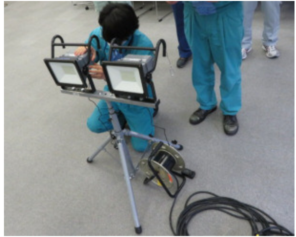
バッテリーの外観点検
