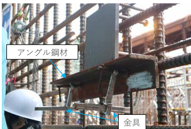
金具を使用して緩みなくアングル鋼材と鉄筋を取付けている様子
