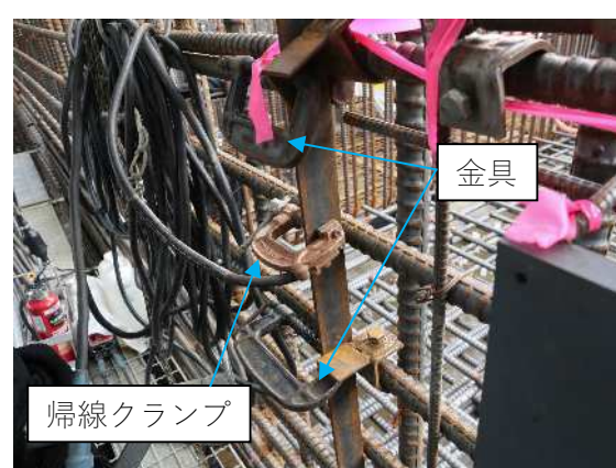
金具を使用して緩みなくアングル鋼材と鉄筋を取付けている様子
