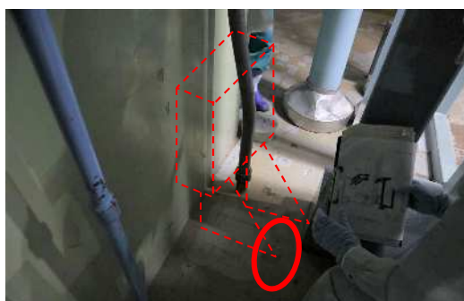
② 金属脚と鋼材の接触箇所（赤丸部）
