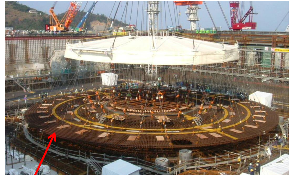
原子炉建物の配筋工事の状況
