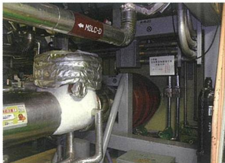
耐震補強工事前
