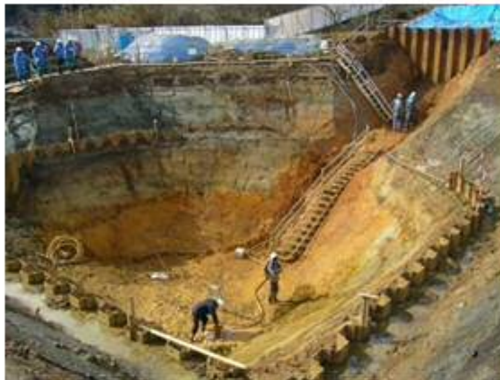
トレンチ調査状況
