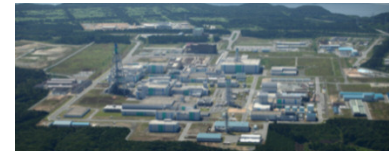
日本原燃(株)再処理工場※2 (平成30年度上期竣工予定)
