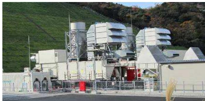
約40mの高台に設置したガスタービン発電機(自主対策)
