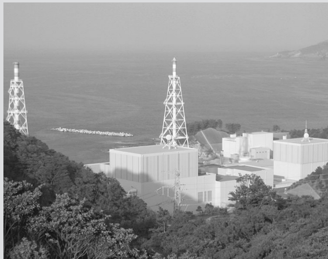
島根原子力発電所
