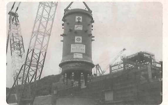
平成21年7月17日：原子炉圧力容器の吊り込み作業
