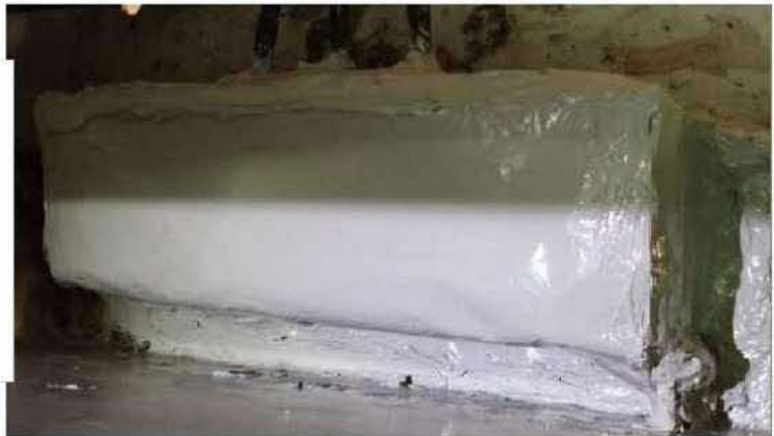
補修材による修理状況
