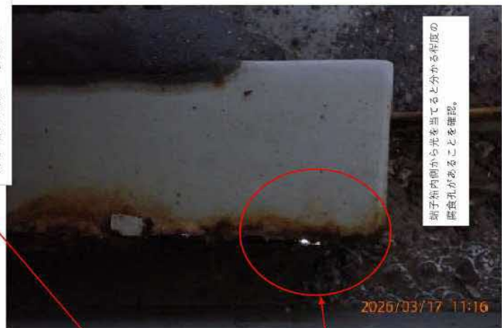
端子箱天板の状況 2
