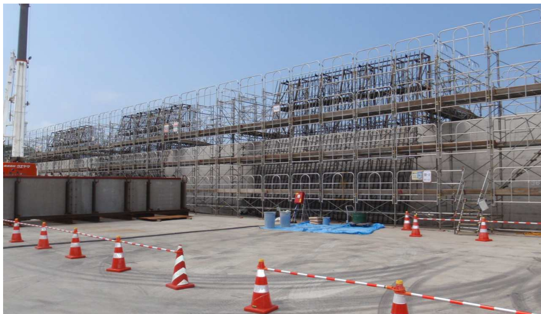
防波壁工事の状況
