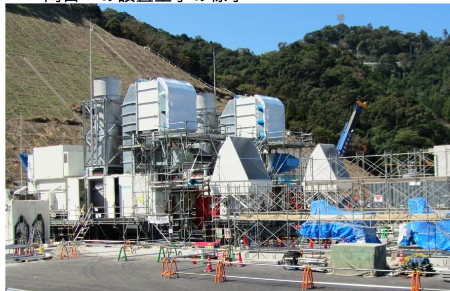
高台への設置工事の様子
