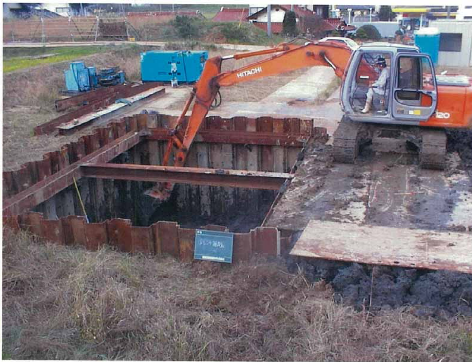
2004年の仲田におけるトレンチ掘削調査の状況
