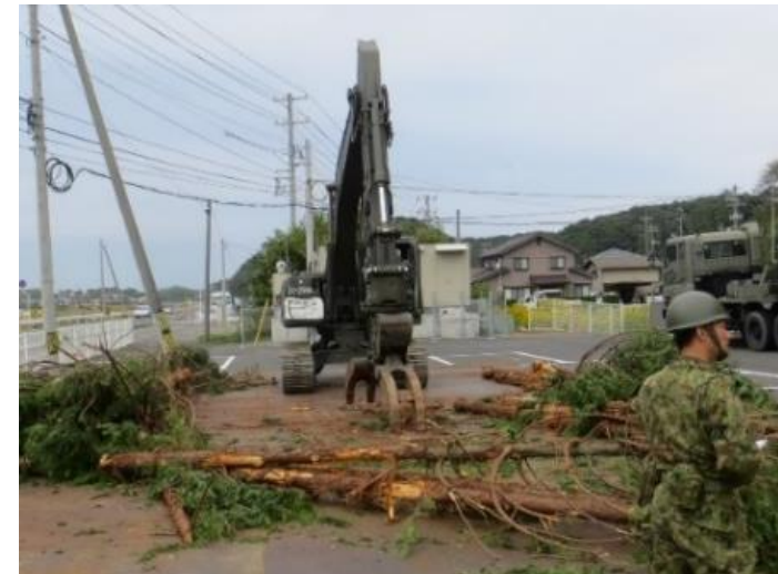
道路上の倒木を自衛隊が重機を使用し撤去
