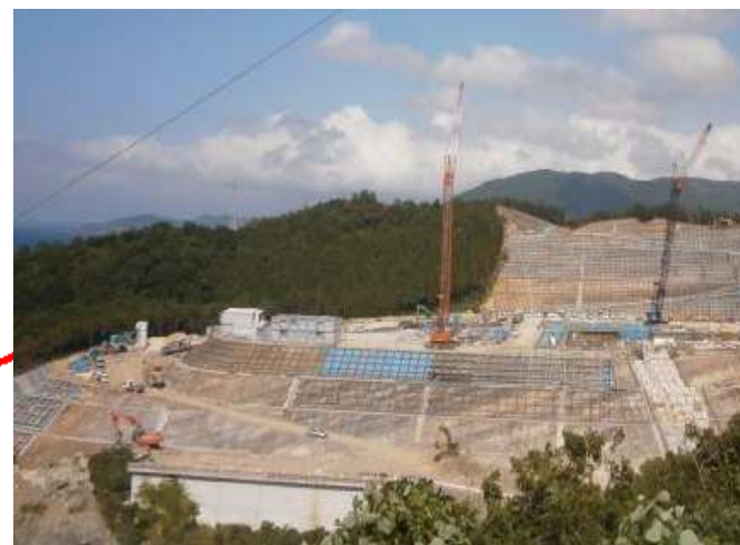
▲免震重要棟設置工事状況
