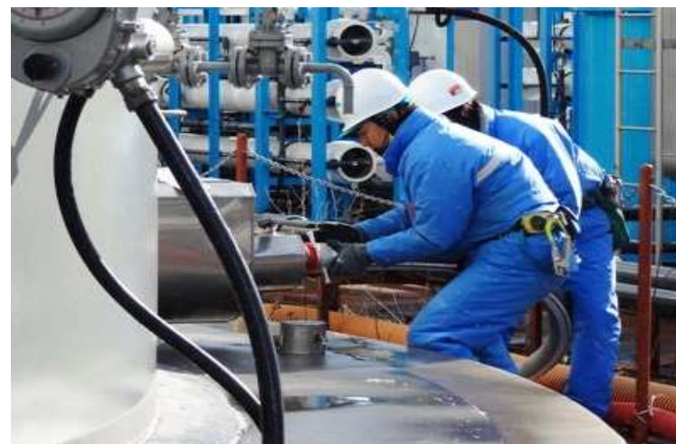
▲代替注水訓練 (水源となるタンクへの接続)
