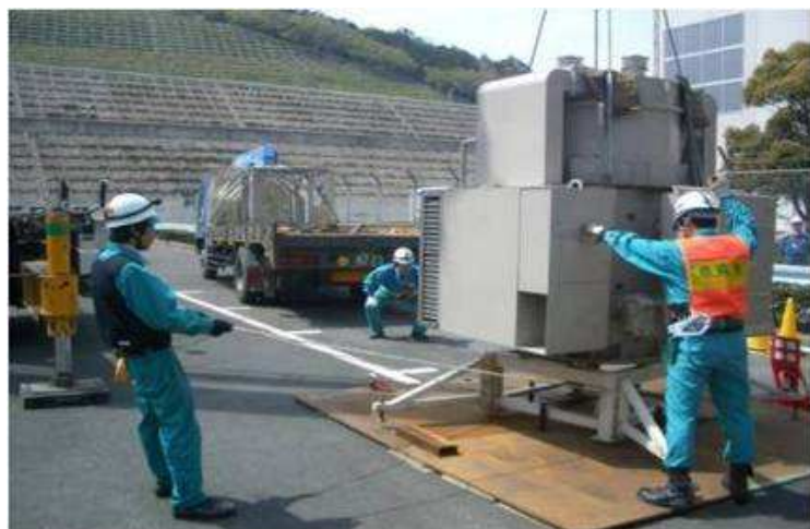
▲原子炉補機海水ポンプ電動機取替訓練
