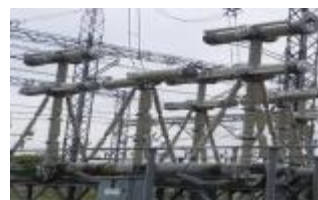
275kV空気遮断器(ABB) (出典)第1回電気設備地震対策WG資料
