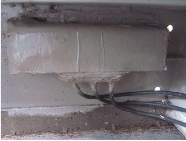
No. 3 端子箱天板の補修状況（他系統も同様）
