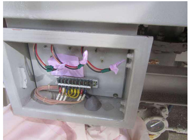
冷却ファン端子箱（側面と内部）
