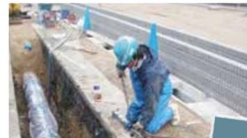
地中の水道や下水道の本管と呼ばれる太い管の導水管を、布設、交換する仕事です。
