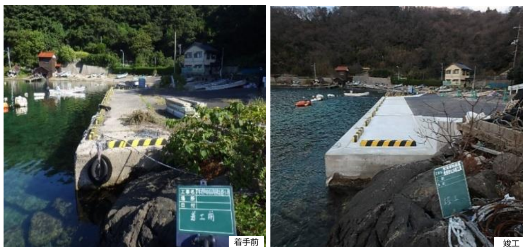
物揚場施設の長寿命化対策
