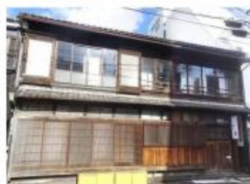
旧米江旅館本館(南棟)
