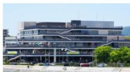
グランドオープンイベントでの新庁舎の様子
