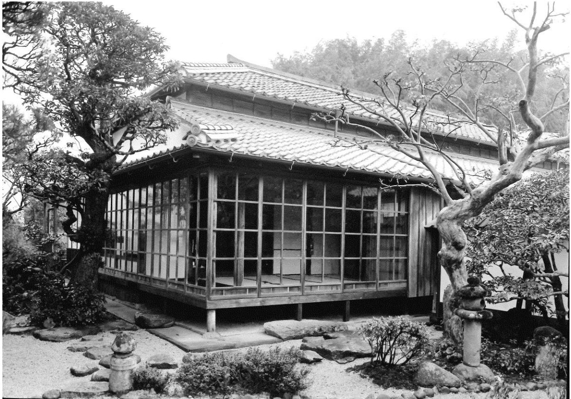
昭和 58 年(1983)修理竣工写真
