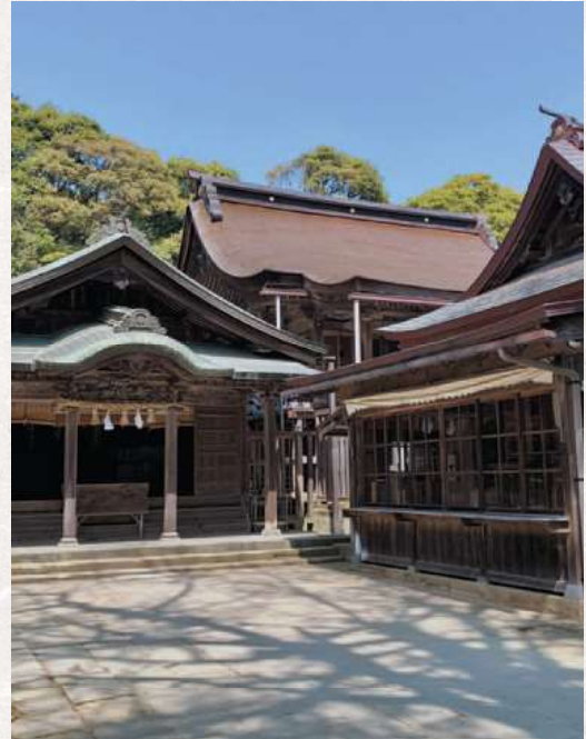
平浜八幡宮社殿 (松江市八幡町)
