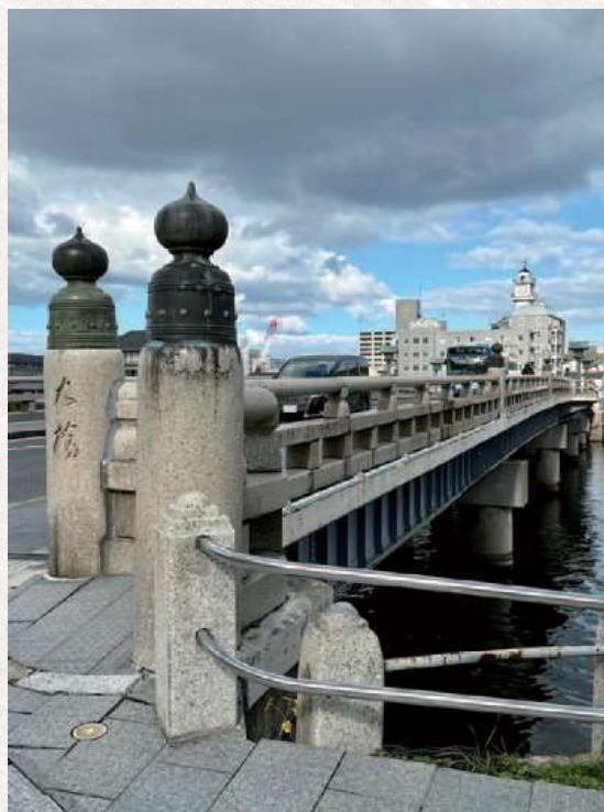
松江大橋（南詰から）
