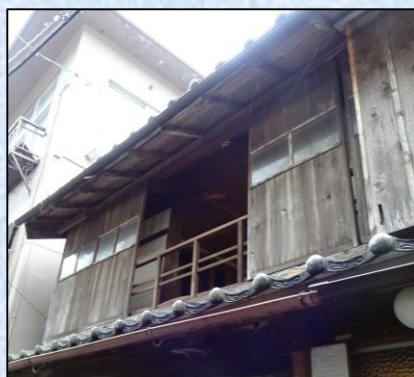
2階窓際に設けられている手摺
