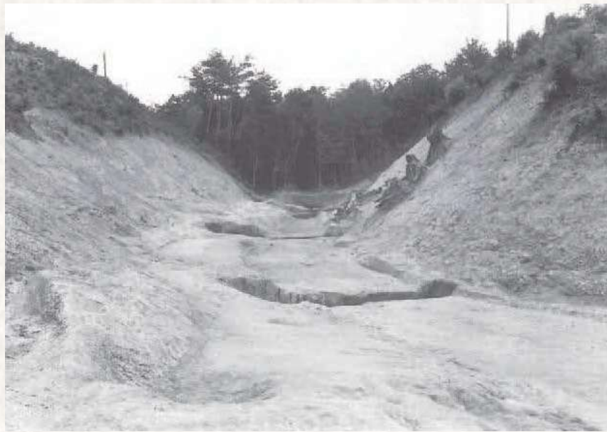
松本古墳群の谷を切り割った古代山陰道跡
