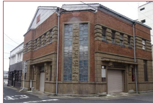
外壁洗浄、塗装
