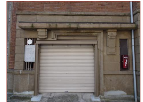
北側入口鉄骨フレーム補強
