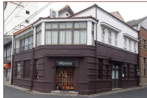
外壁洗浄、塗装
